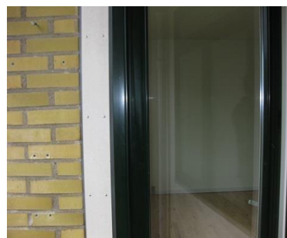
Figur 4 Eksempel på del af altandør med grøn aluminiumsprofil
